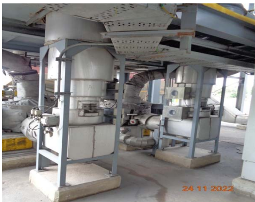
รูปที่ 7 ระบบควบคุม SO 2 และ HCl แบบ Dry-absorption System
