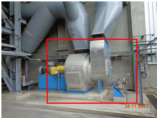
รูปที่ 15 พัดลมดูดอากาศ (Primary Air Fan) ของหม้อไอน้ำ
