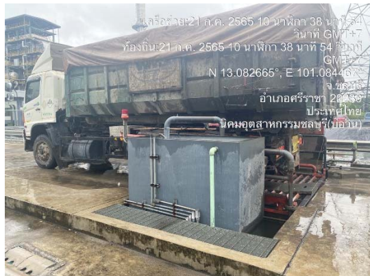
รูปที่ 25 ปัมควบคุมน้ำที่กลับมาใช้รดน้ำต้นไม้
