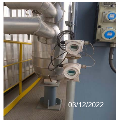
รูปที่ 78 อุปกรณ์ตรวจวัดอุณหภูมิของหม้อไอน้ำ
