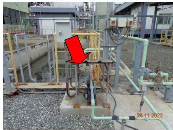
รูปที่ 25 ปัมควบคุมน้ำที่กลับมาใช้รดน้ำต้นไม้
