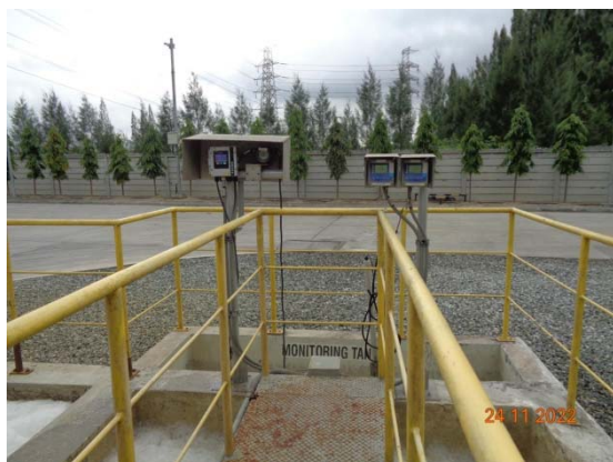
รูปที่ 37 เครื่องตรวจวัดคุณภาพน้ำทิ้งแบบอัตโนมัติ บริเวณบ่อพักน้ำทิ้งที่ 1 และบ่อพักน้ำทิ้งที่ 2
