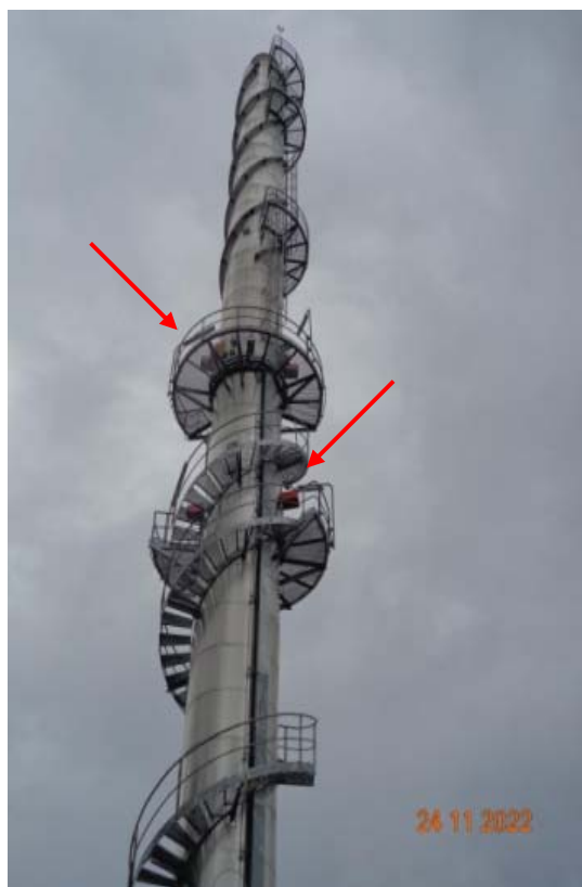
รูปที่ 11 จุดตรวจวัดมลพิษก่อนระบายออกของปล่อง Boiler (CEMs)
