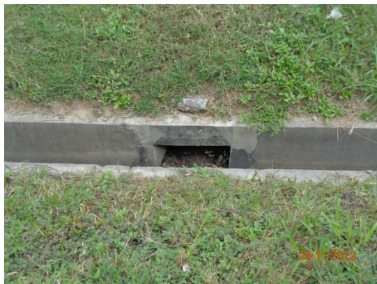
รูปที่ 40 จุดเชื่อมต่อรางระบายน้ำฝน ของโครงการกับนิคมฯ
