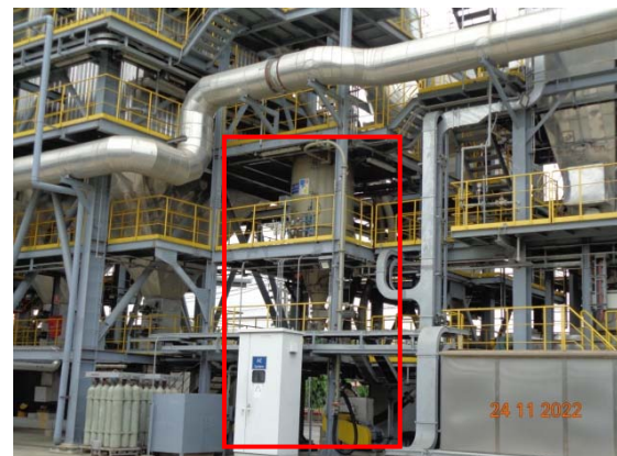
รูปที่ 8 ระบบฉีดพ่นผงถ่านกัมมันต์เพื่อดูดซับ โลหะหนัก และสารประกอบไดออกซิน
