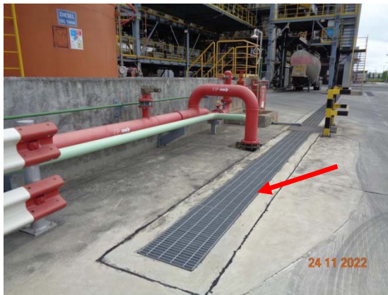
รูปที่ 29 รางระบายน้ำฝนปนเปื้อน
